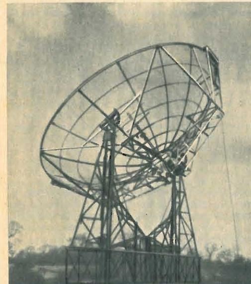
● Il paraboloide della Stazione di Godrell Bank (Inghilterra). Esso lavora su una larga banda di frequenze, potendo porre nel fuoco diversi aerei.
