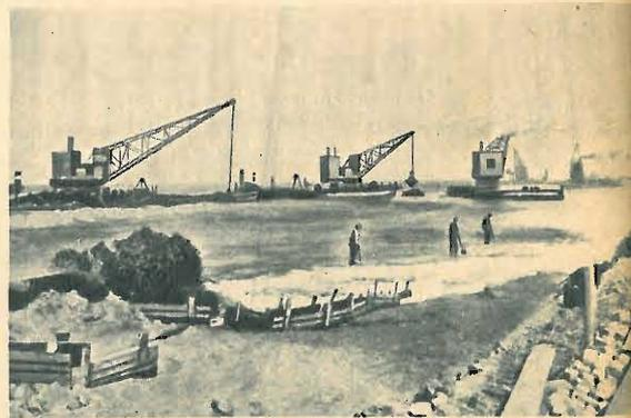
● Fra le due massicciate fu versata quindi la sabbia che doveva formare il corpo stesso dell'argine. Questo riempimento fu eseguito da gru galleggianti.
