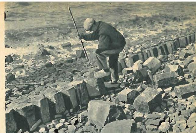
● La parte dell'argine esposta alla risacca è difesa mediante blocchi di basalto di forma esagonale.
