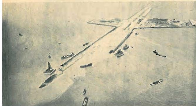
● La costruzione del grande argine di chiusura incominciò al centro con quella di un'isola, la Breezand; vi furono allestiti 2 porti, depositi e ripari.
